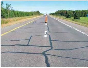
Le scellement de fissures constitue la seule intervention proposée dans la famille de l'entretien préventif. Les chaussées plus récentes (revêtement usuellement vieux de 1 à 6 ans)<sup>6</sup> et peu fissurées sont généralement candidates à ce type de recommandation.
