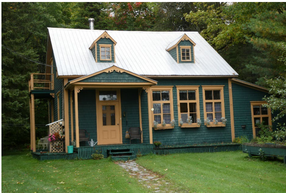
Ancienne école de rang. Maison couverte en bardeau, sise au 648, rang Saint-Pierre à Saint-Narcisse. Photographie de Jean-Pierre Chartier.
