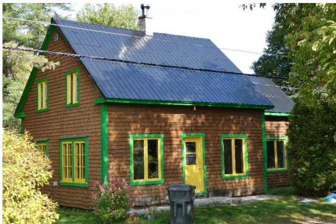
Maison à deux versants droits, avec retours de l'avant-toit. Maison sise au 220, rang de la Rivière-à-la-Lime, à Sainte-Geneviève-de-Batiscan. Murs recouverts en bardeaux de bois. On n'a pas oublié les chambranles. Photographie de Jean-Pierre Chartier.
