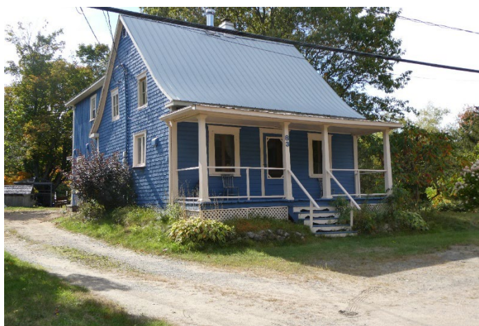
Maison québécoise à deux versants galbés, avec retours de l'avant-toit. Notez le revêtement des murs en bardeaux de bois. Modèles sans lucarne à 1 1/2 étage. Une cuisine d'été s'accroche au mur arrière du corps principal. Photographie de Jean-Pierre Chartier.
