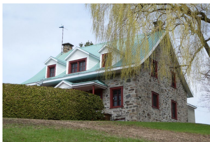
Maison Rouillard-Pronovost, sise au 301, rang du Village-Jacob à Sainte-Geneviève-de-la-Batiscan. Bâtiment de pierre à deux versants galbés, avec ses trois lucarnes et ses fenêtres traditionnelles. Construite vers 1785 selon le RPCQ. Photographie de Jean-Pierre Chartier.
