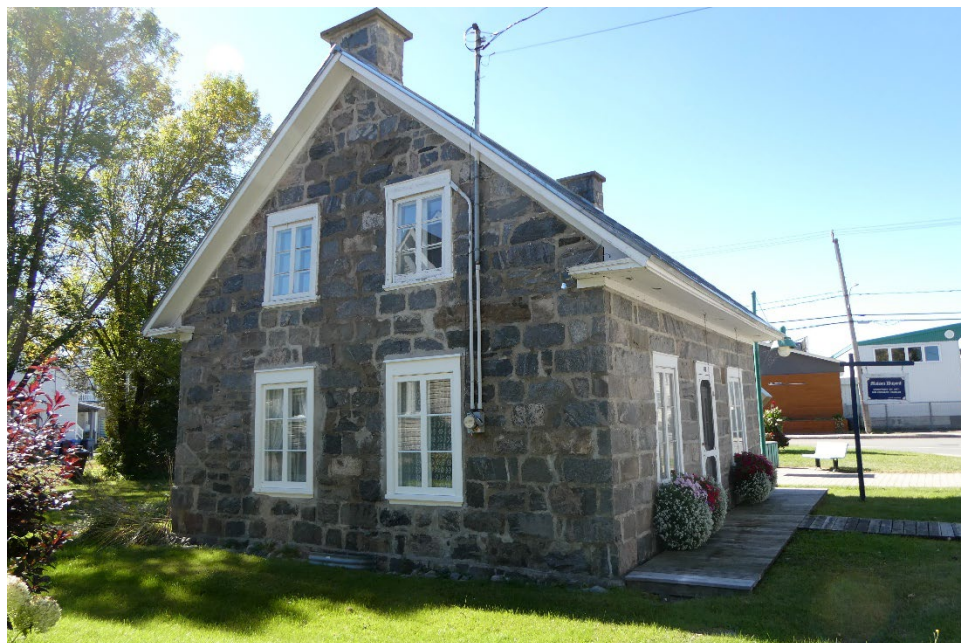
Maison Dupont. Murs en pierres de gneiss grossièrement équarries, sise au 351, rue Principale à Saint-Narcisse. Photographie de Jean-Pierre Chartier.
