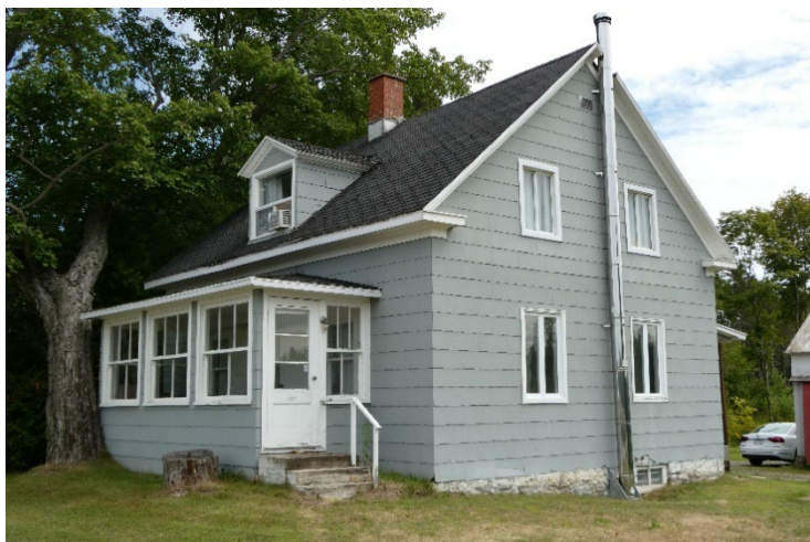
Bardeau d'amiante de forme rectangulaire. Maison sise au 1800, rang Saint-Félix à Notre-Dame-du-Mont-Carmel. Photographie de Jean-Pierre Chartier.
