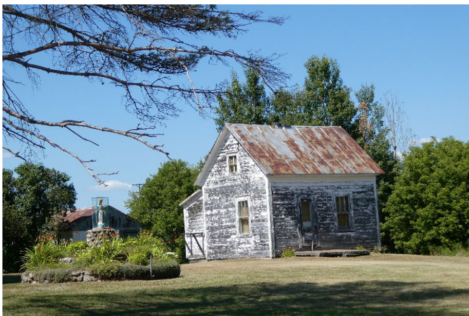
Maison du colon sise au 3921, rang Saint-Alexis à Saint-Luc-de-Vincennes. Remarquez la simplicité du bâtiment, avec des murs revêtus de planches de bois à feuillure et le toit en tôle pincée. Photographie de Jean-Pierre Chartier.
