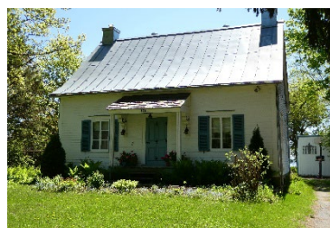
Maison à deux versants galbés du milieu du 19 e siècle, sise au 872, rue Notre-Dame, Champlain
