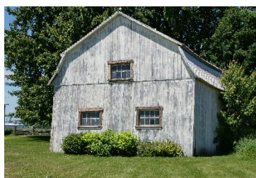
Hangar à deux versants brisés, sis au 75, rue Principale, Batiscan
