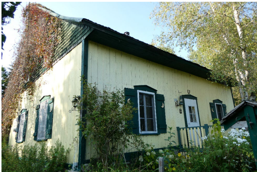
Planche verticale au premier étage et bardeaux de bois au pignon. Maison sise au 2101, rang Saint-Charles à Saint-Proper. Photographie de Jean-Pierre Chartier.
