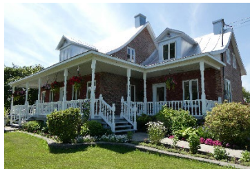
Maison à 2 versants recourbés, avec cuisine d'été, sise au 155, rue Principale, Batiscan
