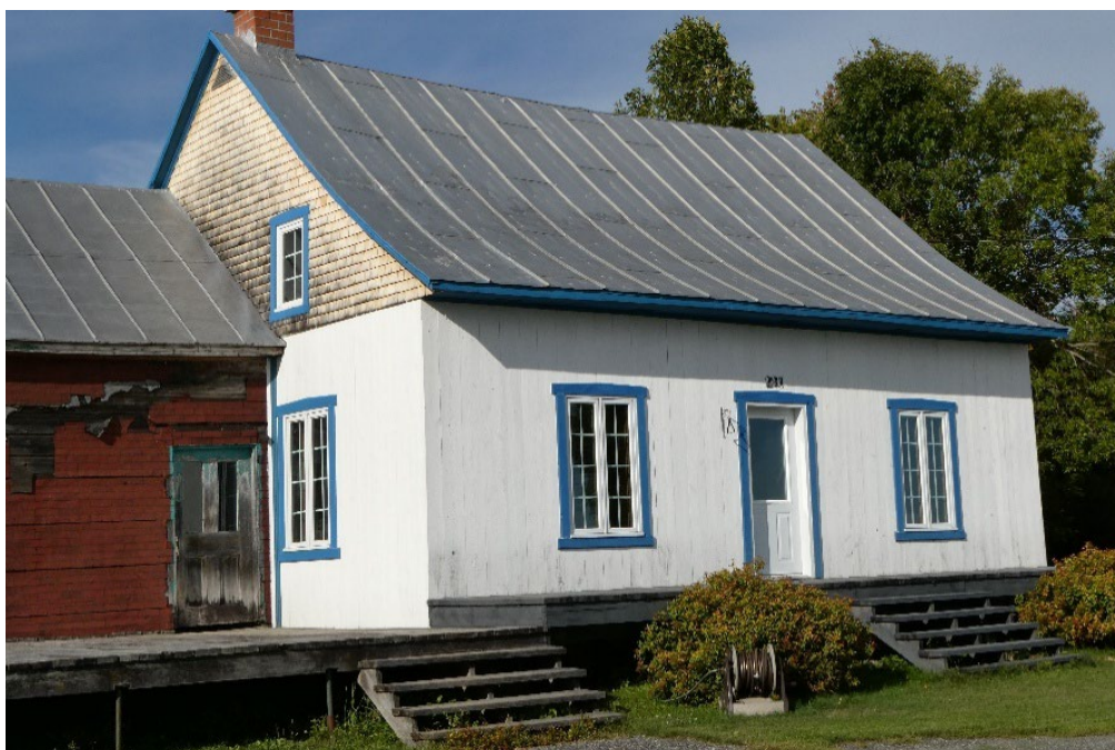
Larges planches verticales au corps principal, avec du bardeau de bois au mur pignon. Maison sise au 231, rang Sainte-Élisabeth à Saint-Proper. Photographie de Jean-Pierre Chartier.
