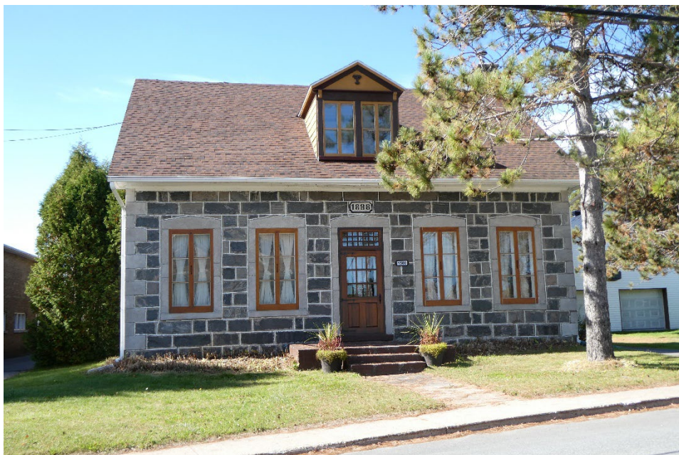
Maison en pierre de gneiss taillée, avec des chambranles et des chaînes d'angle en pierre calcaire. Maison sise au 1500, rue Principale à Saint-Stanislas. Photographie de Jean-Pierre Chartier.
