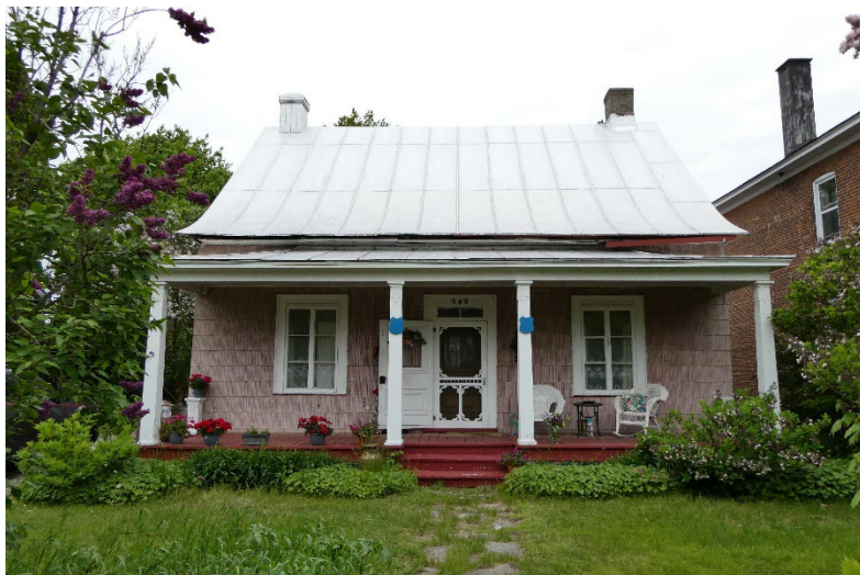
Bardeau d'amiante rainuré de forme rectangulaire. Maison sise au 949, rue Notre-Dame à Champlain. Photographie de Jean-Pierre Chartier.
