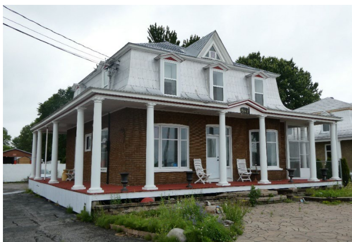
Maison Laquerre, sise au 941-43, rue Principale à Batiscan. Maison dite à la Mansart. Construite entre 1900 et 1915. Photographie de Jean-Pierre Chartier.
