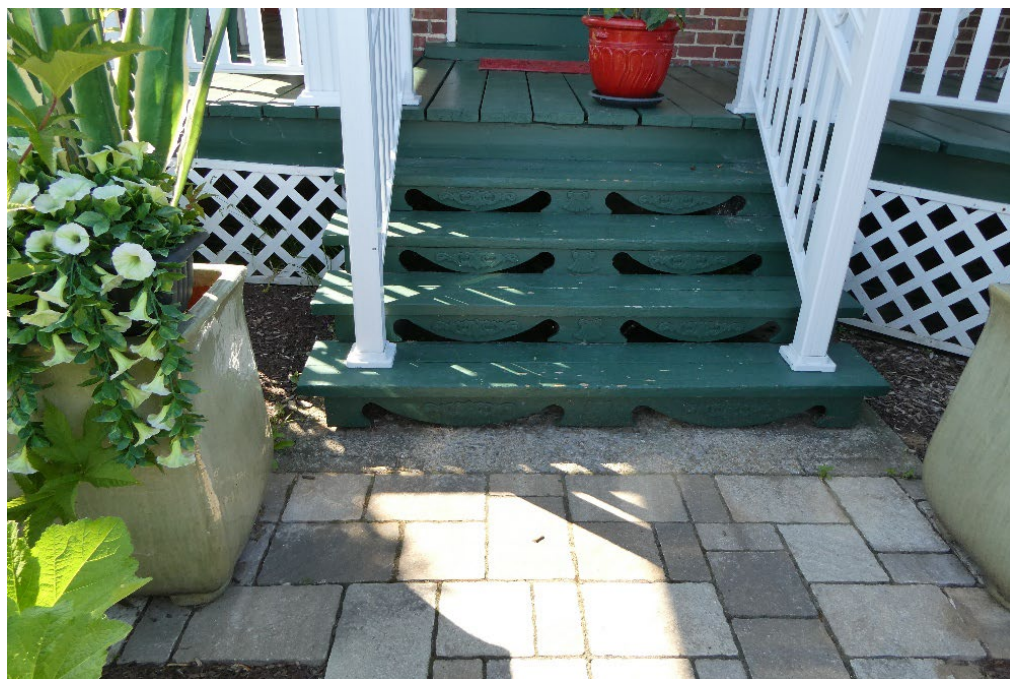
Modèle de contremarche intéressant ajoutant plus de légèreté à l'escalier. Maison sise au 881, rue Principale à Batiscau. Photographie de Jean-Pierre Chartier.
