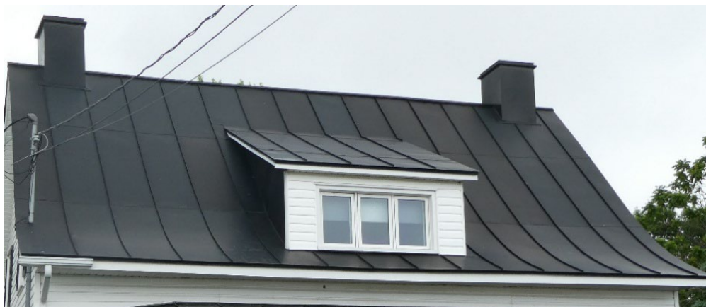
Lucarne rampante à trois ouvertures (triplet) coiffé d'une tôle pincée. Maison sise au 991, rue Principale à Batiscan. Photographie de Jean-Pierre Chartier.
