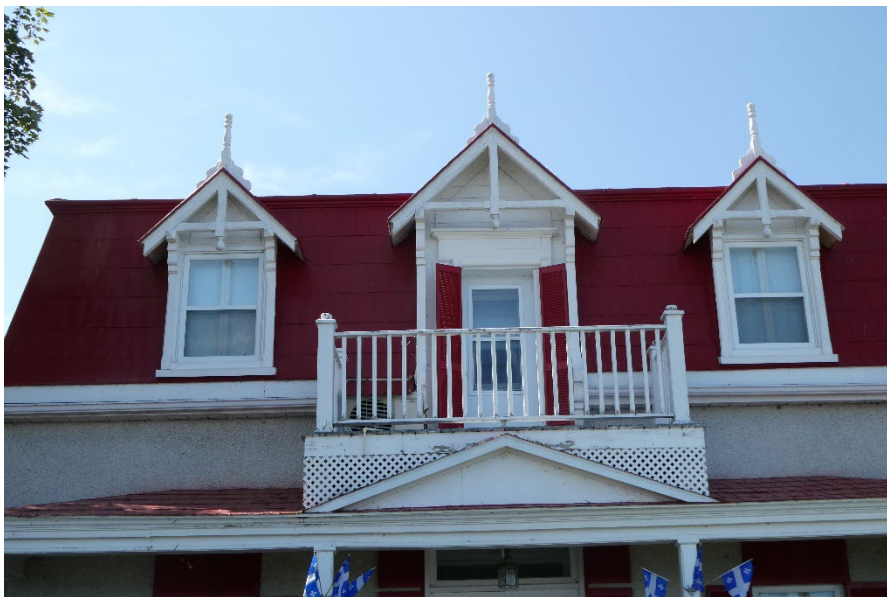
Lucarne-balcon muni de larges consoles, chapeauté d'un épi. Maison sise au 731, rue Principale à Batiscan. Photographie de Jean-Pierre Chartier.
