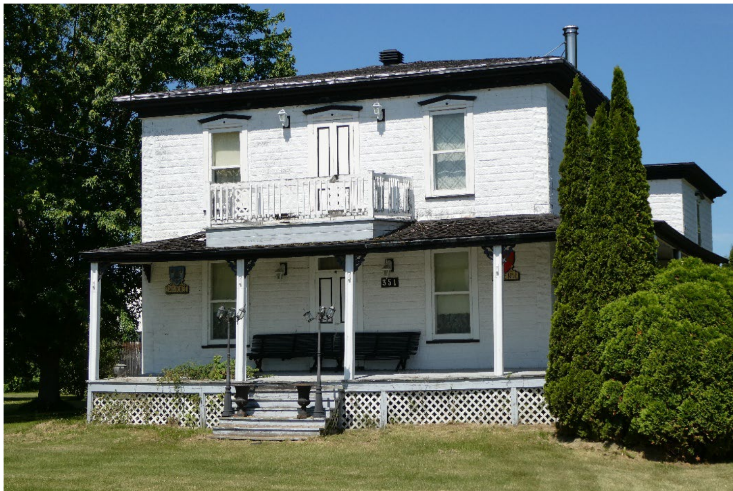
Murs couverts en tôle embossée. Maison sise au 351, rue Principale à Batiscan. Photographie de Jean-Pierre Chartier.
