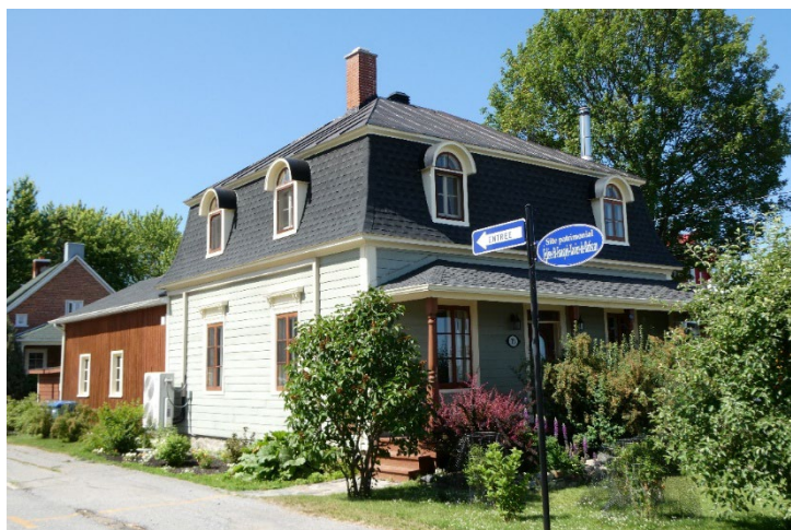
Maison Lehoullier, sise au 721, rue Principale à Batiscan. Modèle à 4 versants brisés, avec brisis incurvés, dit aussi à la Mansart. Photographie de Jean-Pierre Chartier.
