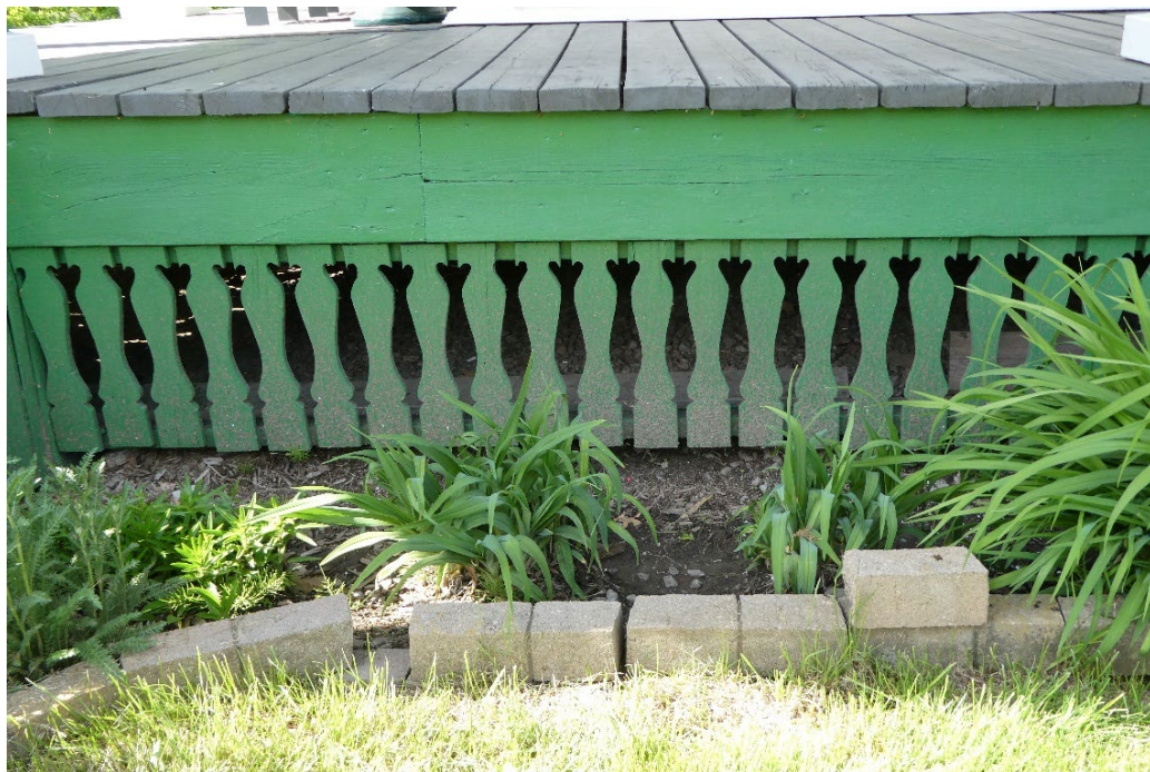
Intéressante jupe de galerie munie de planchettes découpées fixées sous le madrier. Maison sise au 1001, rue Notre-Dame à Champlain. Photographie de Jean-Pierre Chartier.
