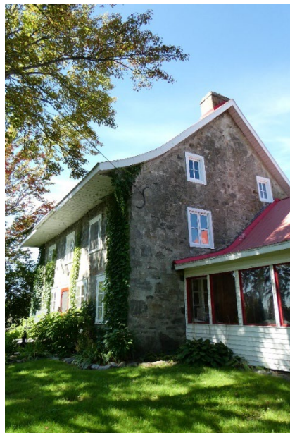
Maison Massicotte, sise 220, rang Saint-Augustin à Saint-Proper. Maison de pierre à 2 ½ étages, ce qui est très rare dans la MRC. Construite avant la formation du village selon le propriétaire. Photographie de Jean-Pierre Chartier.
