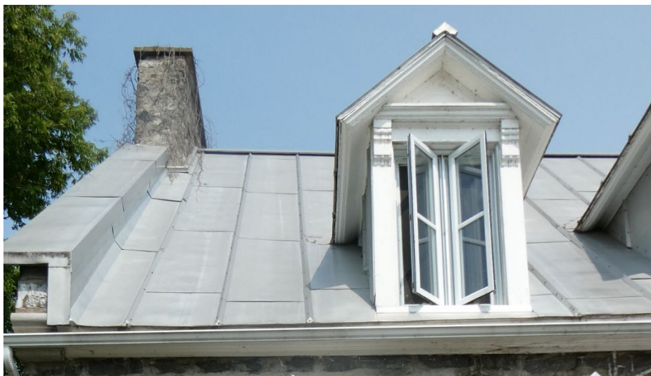
Tôle à baguettes triangulaires, Maison Dauth, sise au 21, boulevard de Lanaudière à Sainte-Anne-de-la-Pérade. Photographie de Jean-Pierre Chartier.
