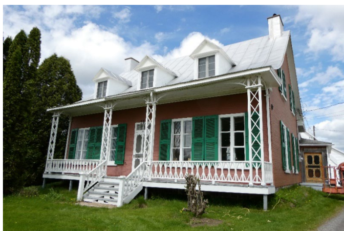
Maison Toupin, sise au 161, rue Notre-Dame à Champlain. Bel exemple de maison à deux versants galbés d'inspiration néoclassique. Construction vers 1860. Photographie de Jean-Pierre Chartier.
